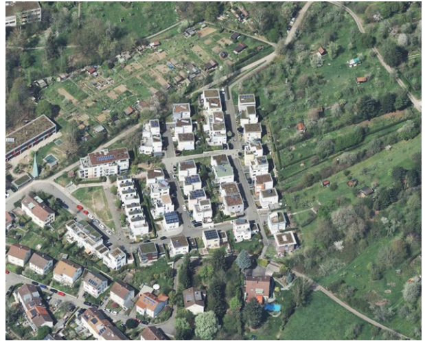
Abb. 23. Schrägluftbild Stadtstrukturtyp Kompakte Mehrfamilienhäuser
