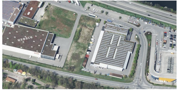
Abb. 62. Schrägluftbild Potenzialtyp Gewerbliche Baulücke
