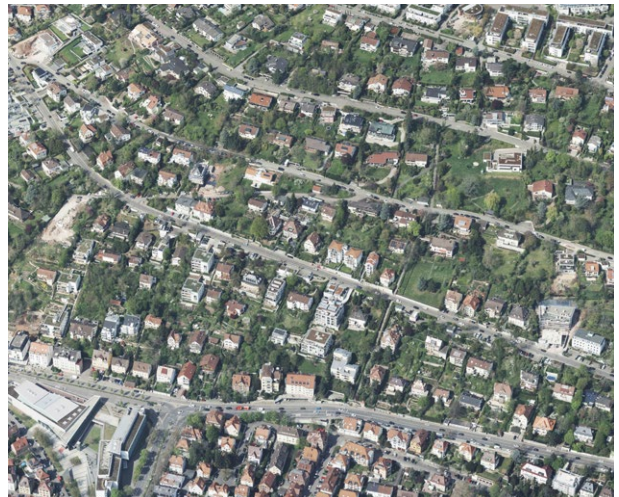
Abb. 27. Schrägluftbild Stadtstrukturtyp Einzel- und Doppelhäuser in Hanglage
